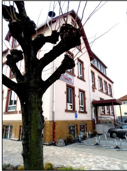
Das Interkulturelle Büro befindet sich im 1. OG
